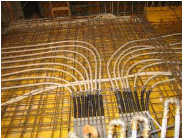
Rohrleitungen zwischen der Bewehrung
