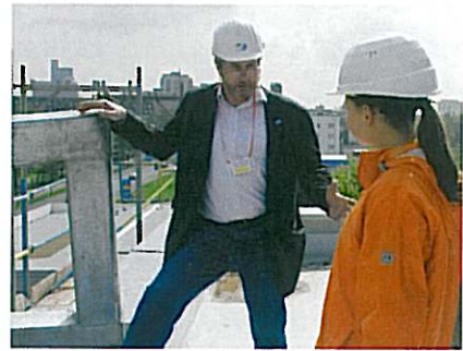
Jörg Rehnitz, Brandi IGH, beim Girls' Day auf der Baustelle
